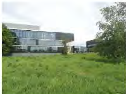
Widok na działkę, w oddali sąsiedztwo – zabudowa biurowa
