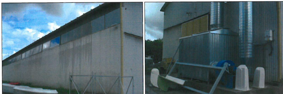
foto 7 - 8. widok ogólny budynku
