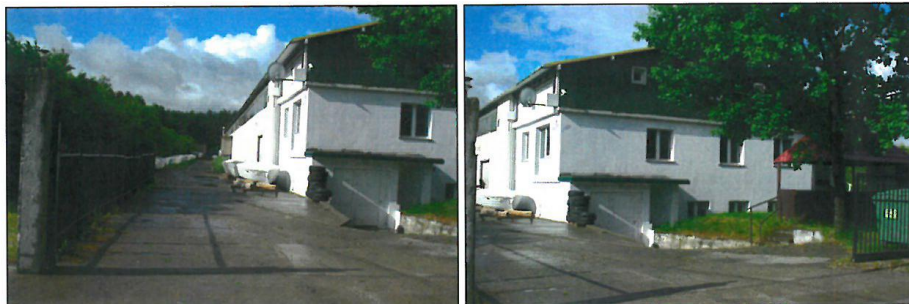
foto 3 - 4. widok ogólny budynku
