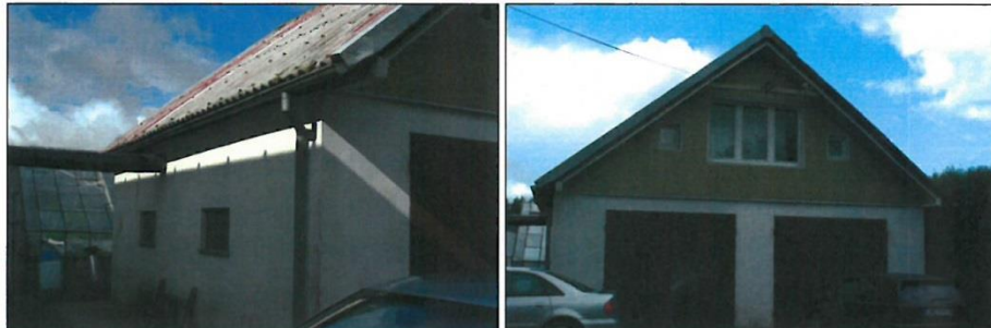
foto. 23 - 24. widok ogólny budynku
