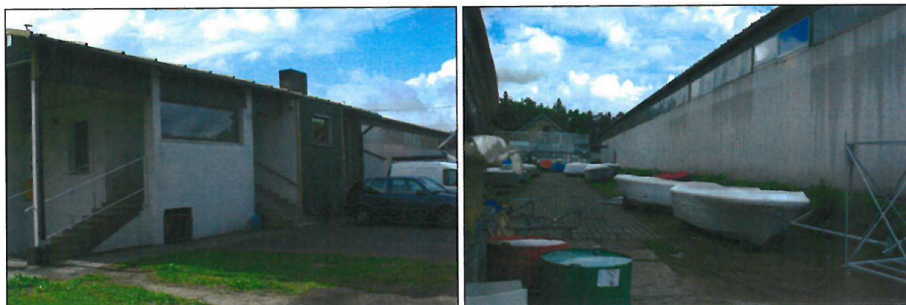
foto 5 - 6. widok ogólny budynku
