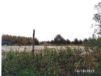
11 Widok nieruchomości od strony zachodniej;
