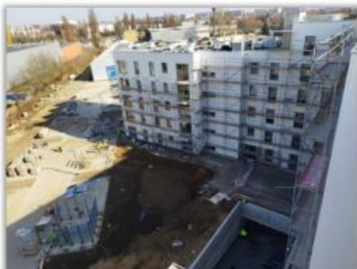
„Junique” etap IA – zdjęcia z budowy
