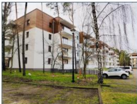
„Stegna Park” etap III
